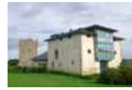
Torre de Villademoros 3*
